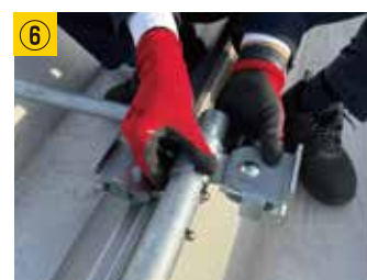
⑥ ボルトを締めハゼ金具を嵌め込む (爪の挿入方向にご注意ください)
