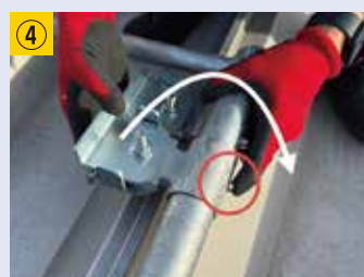
④ 反対側も同様にピンを押しハゼ金具を反転させる
