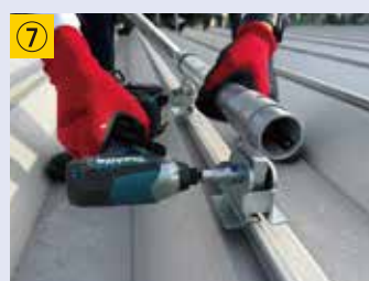
⑦ ボルトを締めハゼ金具を嵌め込む (爪の挿入方向にご注意ください)
