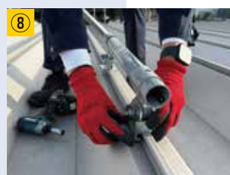
⑦ ボルトを締めハゼ金具を嵌め込む (爪の挿入方向にご注意ください)
