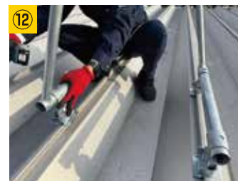
⑫ 反対側も同様の手順でハゼ金具を固定する
