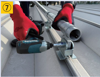
⑦ ボルトを緩めハゼ金具を嵌め込む (爪の挿入方向にご注意ください)
