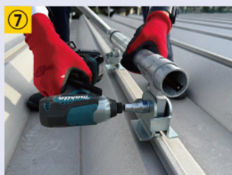
⑦ ボルトを緩めハゼ金具を嵌め込む (爪の挿入方向にご注意ください)
