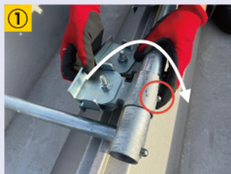
① ピンを押しハゼ金具を反転させる
