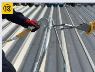
⑬ 全てのボルトを再度締め直し、親綱フックを掛けて完成
