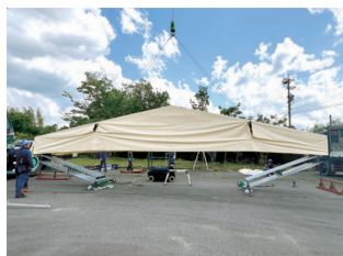
3 現地組立て設置 最短1日で組立て
