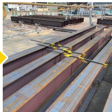
シャフトはネジ鉄筋になっていて専用のナットで爪を固定します。シャフト部分はメッキ処理によりサビの発生率を大幅に軽減することができます。
