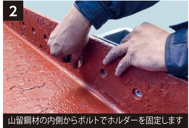
ホルダーを山留鋼材のボルト孔へ差し込みます
