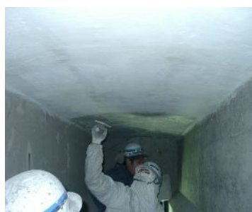
施工写真②
