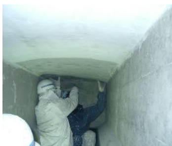
施工写真③
