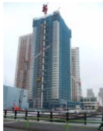
Hi-RC造 垂直ネット施工
