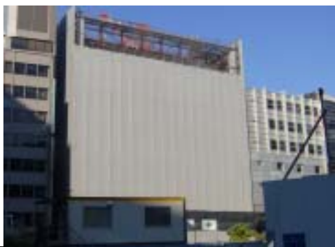
SRC造 外部メッシュ施工
