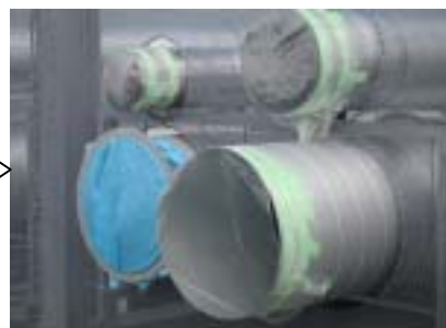
本節ネット工事 ダクト切抜き施工
