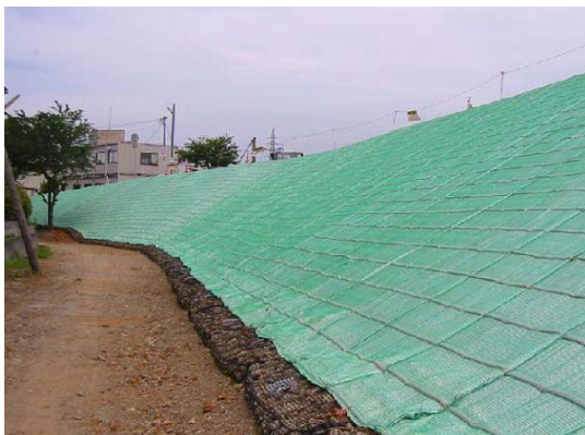
堤外の越水対策
